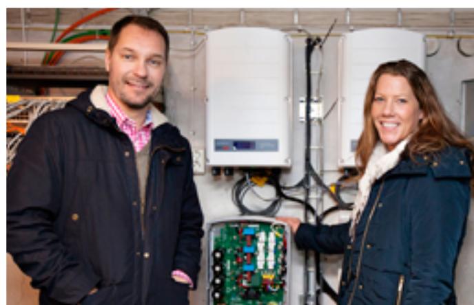
Magnus Bergström, förvaltningschef på Salabostäder och Mari Rydqvist, verksamhetsansvarig på HESAB, vid växelriktarna som omvandlar likströmmen från solcellspanelerna till växelström, redo att brukas i huset.
